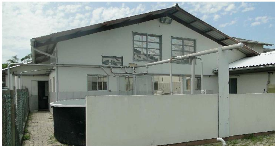
FOTOGRAFIA(S) DA EDIFICAÇÃO
